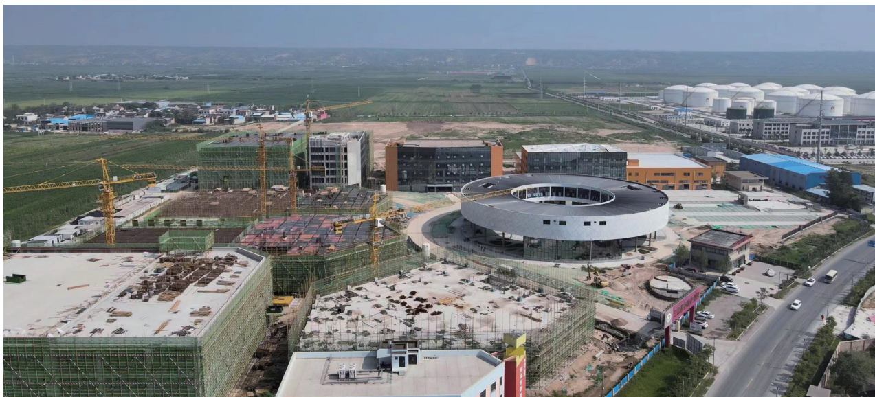
正在建设中的三原香油产业园
