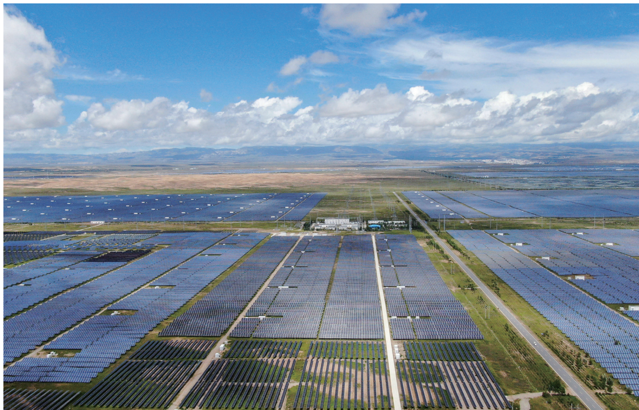
青海省共和县的光伏电站
