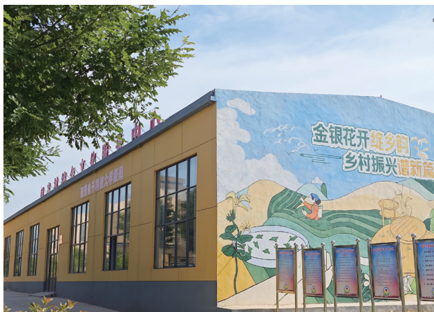
西安电子科技大学援建的闫家村综合文化服务中心
