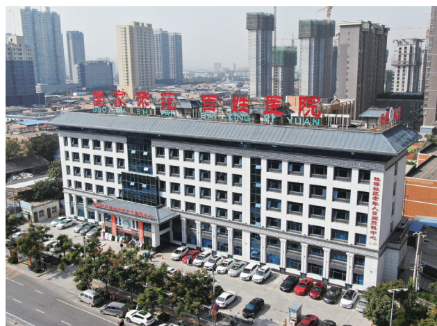
位于渭南市三贤路中段的临渭区杜桥办社区卫生服务中心
