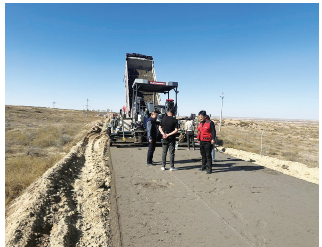
驻嘎查第一书记和工作队注重改善牧区基础设施建设，致力于推动交通、电力、通讯等各方面基础设施的完善和提升。
